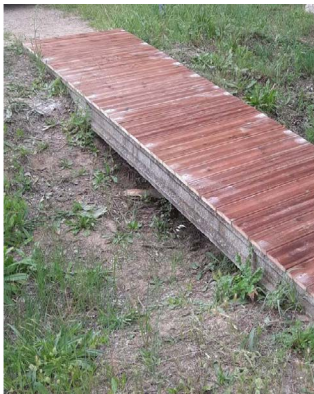
Substitució passera de fusta a Colomers
