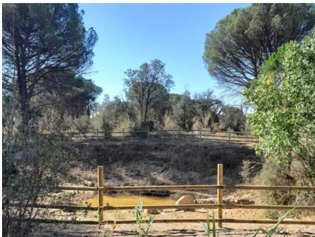
Instal·lació tanca texana a la nova bassa de l'illa d'Avall, Jafre
