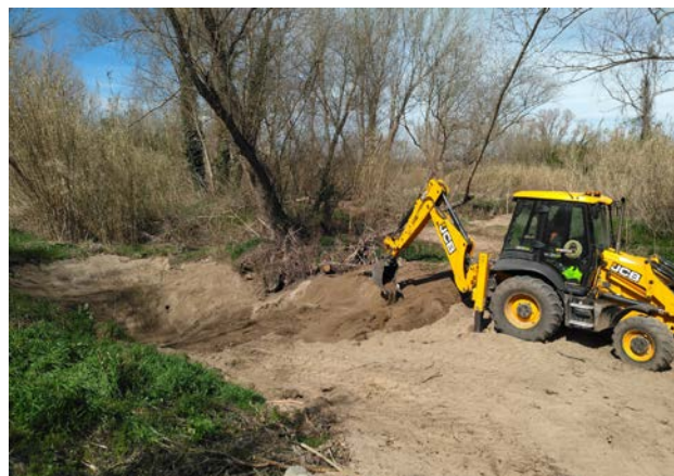
Procés de construcció d'una bassa a la Safa, Sant Julià de Ramis
